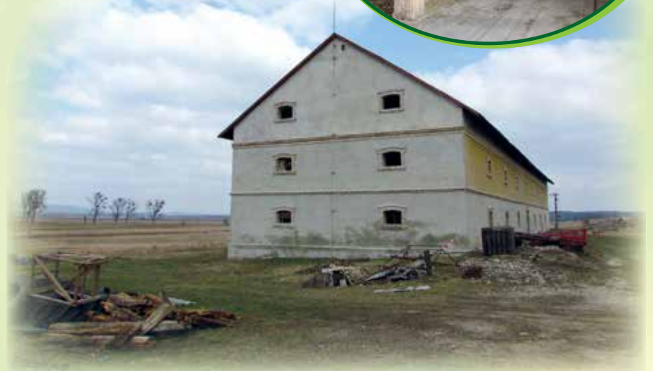
Egy felújítás alatt álló magtárépület a Vértes Natúrparkban
